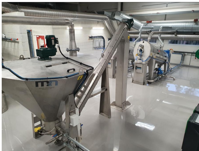
Sandfang og Slamavvanningsskruer
