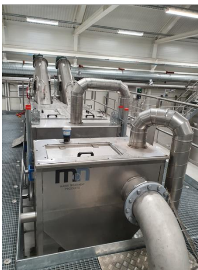
Forbehandling med innløpssiler
